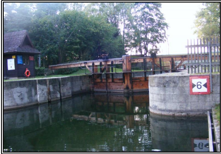
Fotografia 37 Pojezierze Suwalskie, śluza Przewieź , [fotogr. kol.], M. Litak
